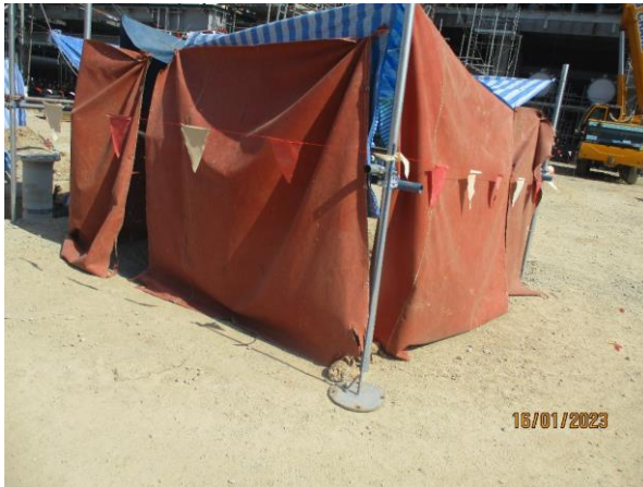
รูปที่ 2-4 การปิดคลุมด้วยผ้าใบทุกด้านเพื่อป้องกัน Copper slag พุ้งออกจากพื้นที่ปฏิบัติงาน
