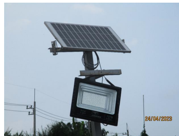
รูปที่ 2-37 ไฟฟ้าส่องสว่างฉุกเฉิน
