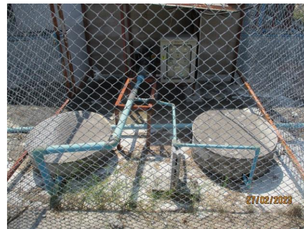
รูปที่ 2-50 ห้องน้ำ ห้องส้วม ที่ติดตั้งระบบบำบัดน้ำเสีย (บ้านพักคนงาน)
